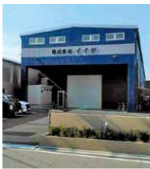
完成した第二新工場
