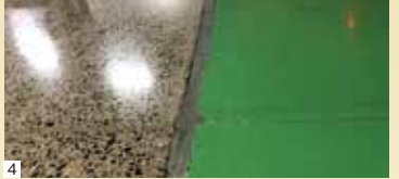
4 興進本社ビル ②③ 鏡面仕上げ機械 ④ 鏡面仕上げで輝く床面(右:研磨前/左:研磨後)
