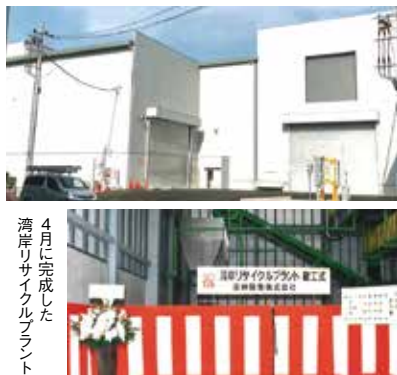
4月に完成した湾岸リサイクルプラント
