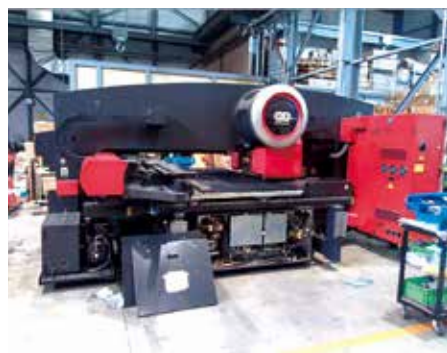
設備のメンテナンスと整備を行う様子
